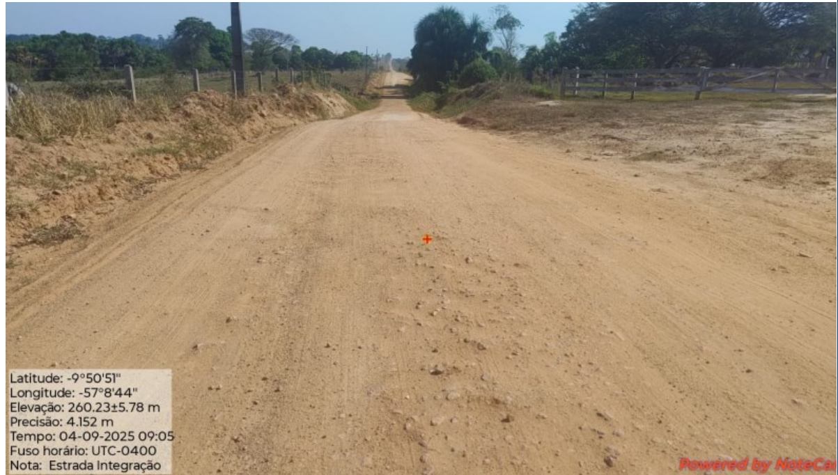
Foto 07: Situação do trecho meio da estrada que sofrerá intervenção
