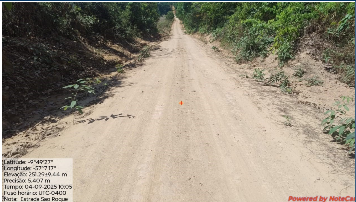
Foto 16: Situação da estrada que sofrerá intervenção
