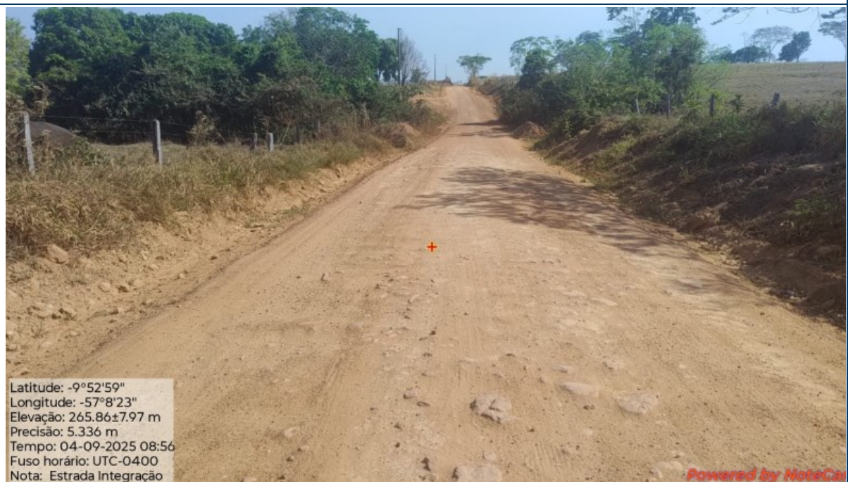
Foto 06: Situação do trecho meio da estrada que sofrerá intervenção
