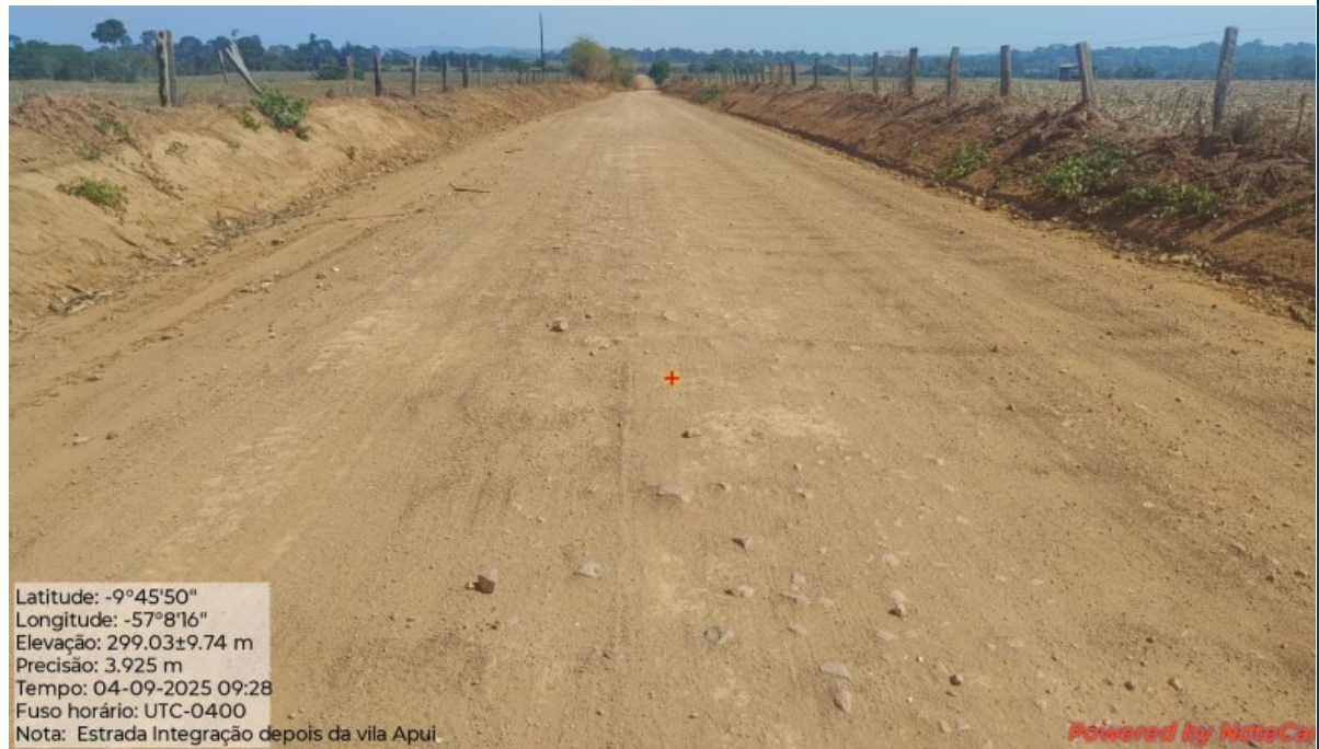
Foto 13: Situação do trecho meio da estrada que sofrerá intervenção
