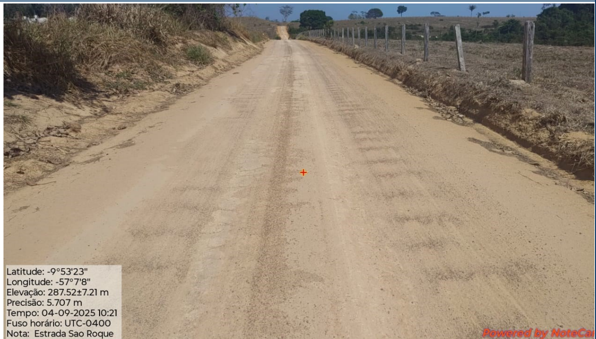
Foto 20: Situação da estrada que sofrerá intervenção
