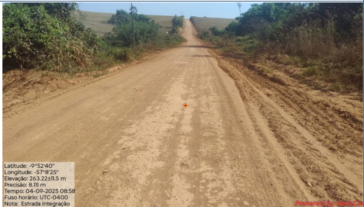
Foto 04: Situação do trecho meio da estrada que sofrerá intervenção
