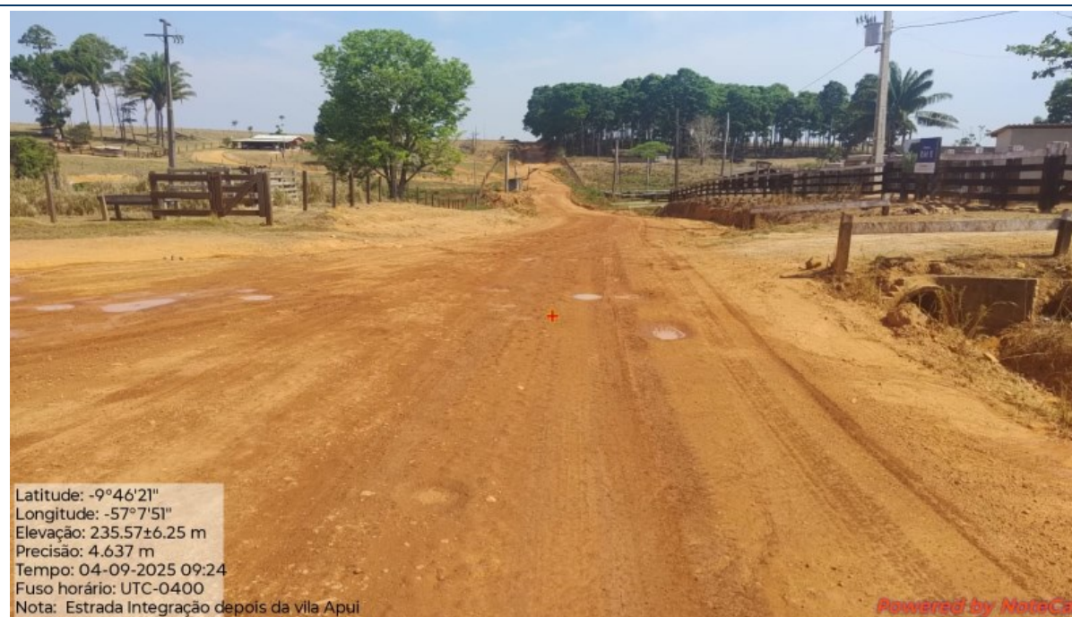
Foto 11: Situação do trecho inicial da estrada que sofrerá intervenção
