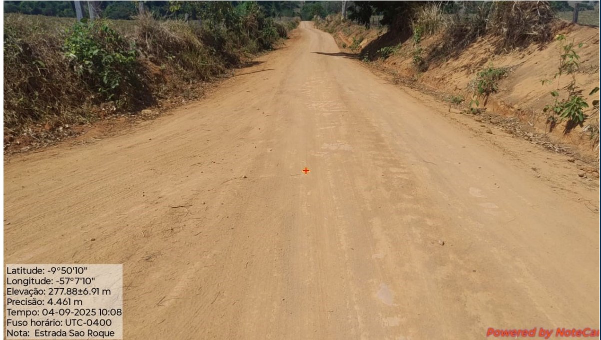
Foto 19: Situação da estrada que sofrerá intervenção
