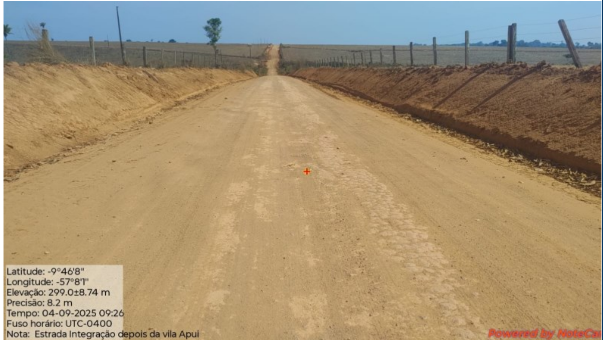
Foto 15 Situação do final do trecho da estrada que sofrerá intervenção
