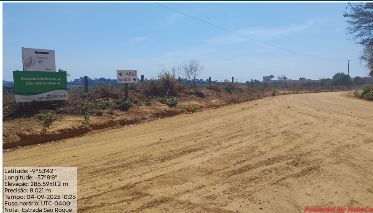
Foto 21: Situação da estrada que sofrerá intervenção
