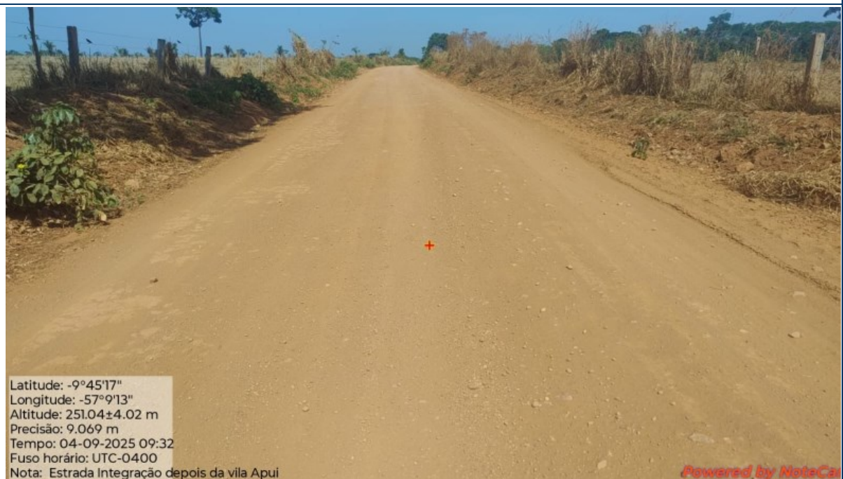
Foto 14 Situação do trecho meio da estrada que sofrerá intervenção
