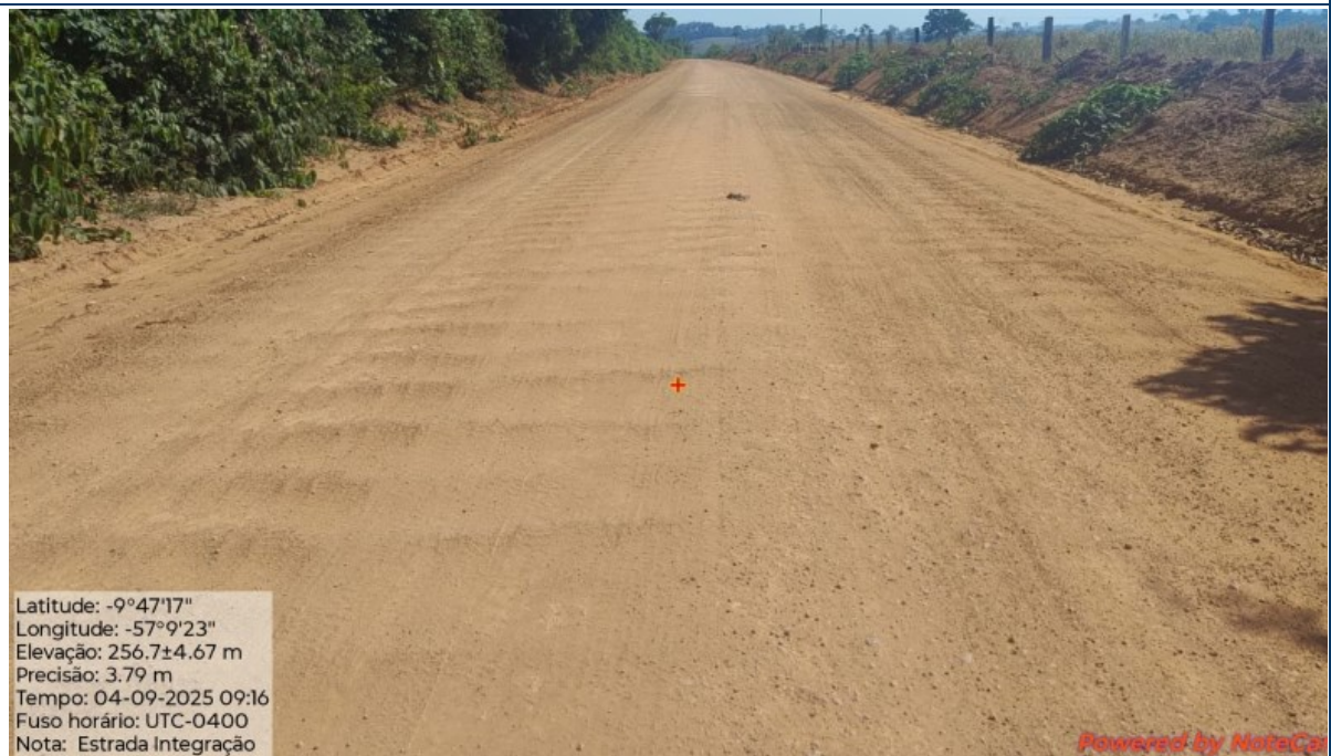
Foto 10: Situação do trecho fim da estrada que sofrerá intervenção
